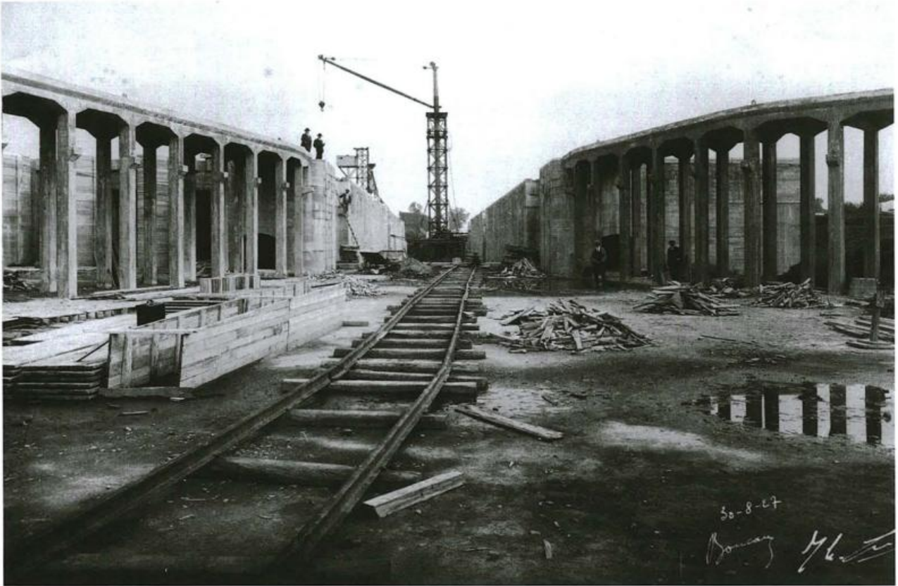
Unieke foto van de aanleg van de nieuwe sluis te Lot. Foto gedateerd: 30 augustus 1927
